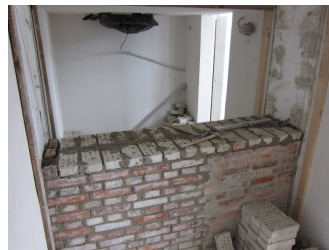
Struttura in costruzione
